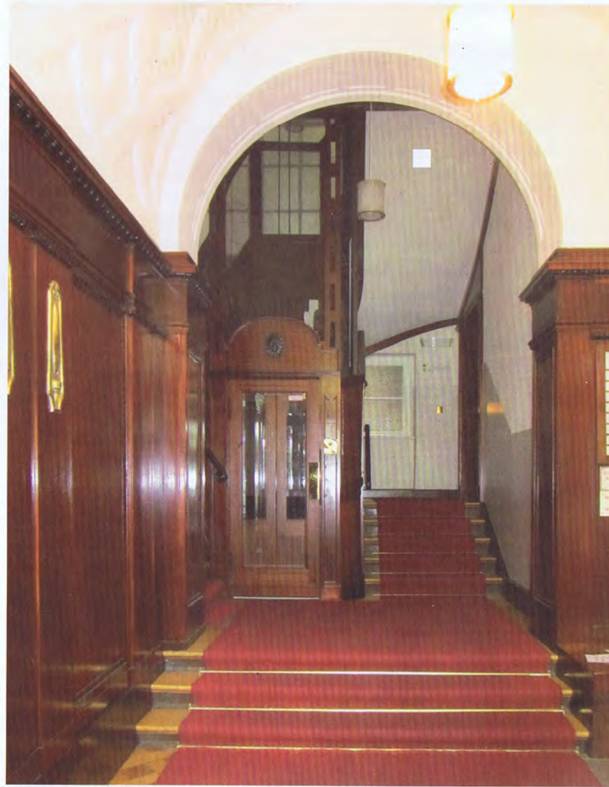
Authentische Identität: Technik und Oberflächen des über 100 Jahre alte Fahrstuhls wurden aufgearbeitet, die Leuchten neu entworfen
